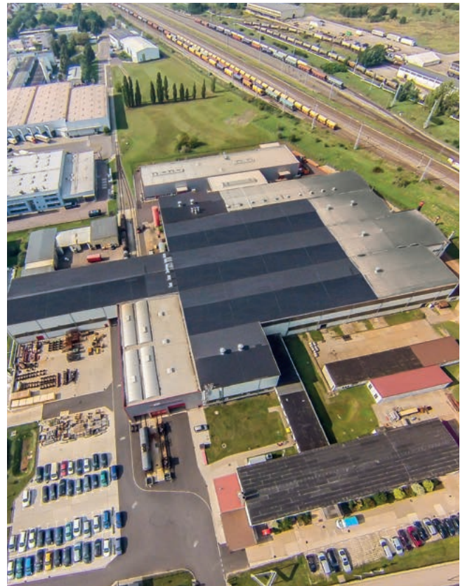
TIP TOP Oberflächenschutz Elbe GmbH in Wittenberg
